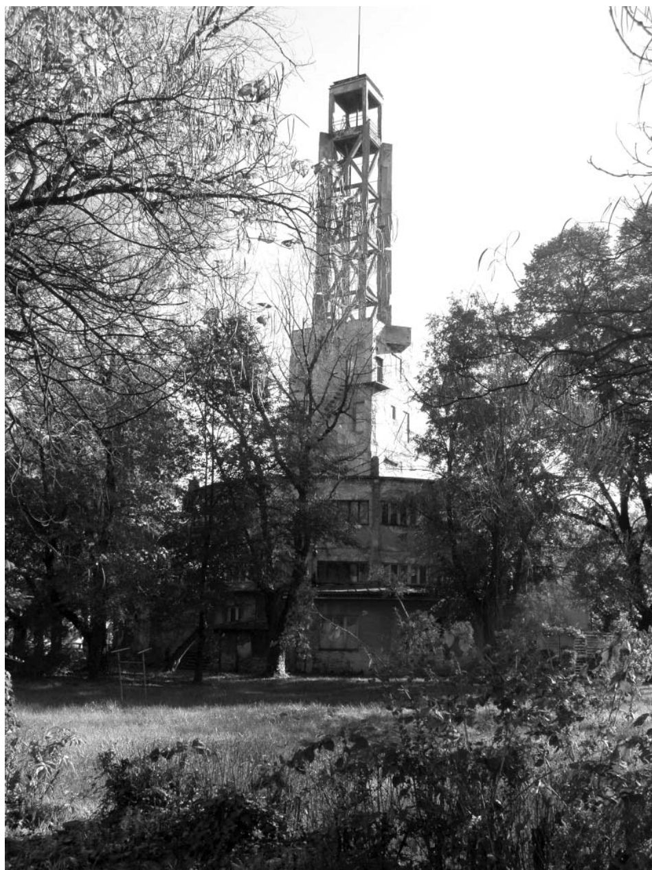
Staro Sajmište dziś – niszczejąca symboliczna wieża (fot. Magdalena Bogusławska)
